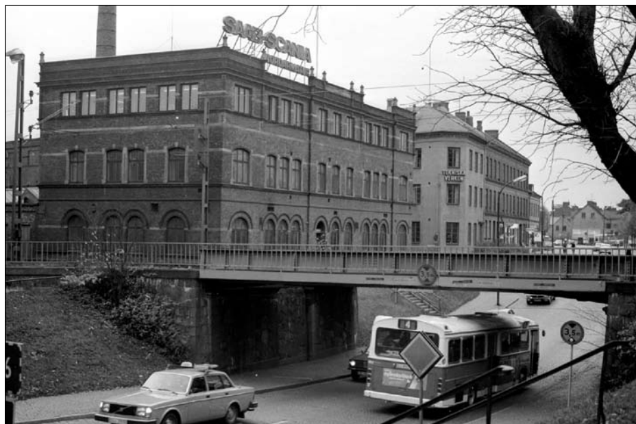
Armaturfabriken och den gamla järnvägsbron vid Trollebergsvägen 1979. Bussen på bilden är en Scania CR 111.
