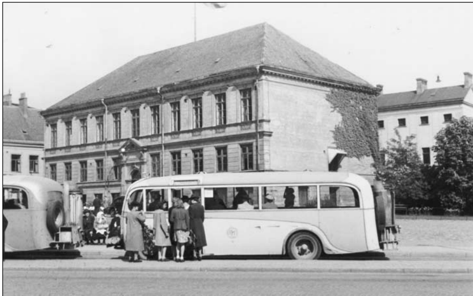
På bilden ser vi buss nummer 5 med gengasdrift. Bussen har den gamla färgsättningen medan bussen framför, av samma typ, har blivit blåmålad. Bilden är sannolikt tagen 1943.
